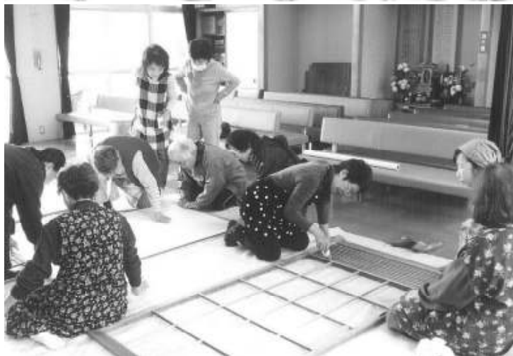
障子張り作業
